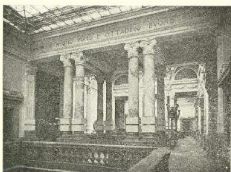
Interno Palazzo Comunale (Vestibolo Uffici)
